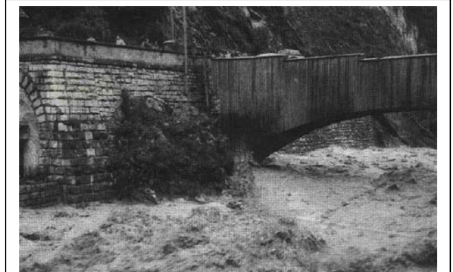
Abb 3: Gerberbrücke in Landeck mit Tunnelportal der Reschenscheideckbahn. Ganz links ist das Tunnelportal erkennbar.
